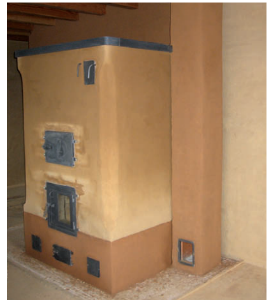
Au cœur de l'habitat, un poêle de masse fait en briques de terre crue qu'ont pressées eux-mêmes Elisabeth et Jean-Michel grâce à une presse fournie par l'association Empreinte (voir page 119). La terre des briques est une terre pure, prise à fleur de sol et tamisée grossièrement : faites en novembre, utilisées en février, les briques ont été complètement sèches en mars-avril.
