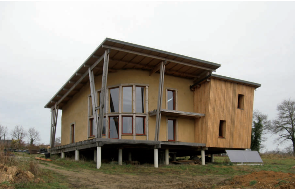
Pour couler ces poteaux de béton, on peut utiliser des moules circulaires (en vente chez les fournisseurs de matériaux), après y avoir introduit ce qu'il faut de « ferraille » pour armer le béton. Il y a une cave qui, au cours des travaux, s'est remplie d'eau entrée... par les gaines électriques. On y a remédié en perçant celles-ci avant qu'elles pénètrent le mur.
