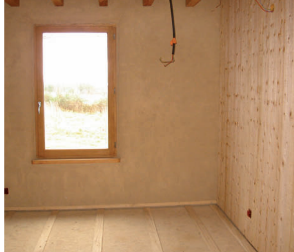
Autre procédé de fabrication pour le mur en terre qui fait face : un mélange terre-paille dans un moule en dalles OSB que l'on accroche aux poteaux verticaux et que l'on fait monter au fur et à mesure de la construction. Le plancher est fait de dalles OSB, sur lesquelles on a placé des tasseaux qui recevront ensuite les lattes du parquet.
